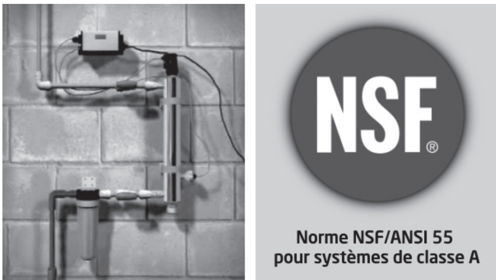
Figure 5.8 Système typique de désinfection par rayonnement UV
